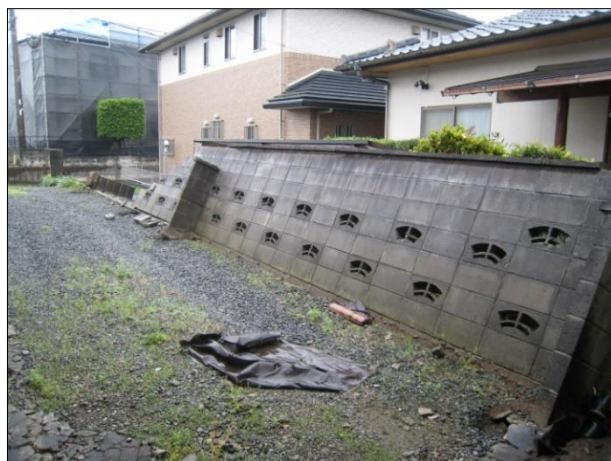
現行基準に適合せず転倒したブロック塀
