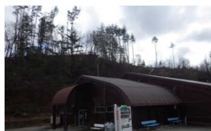
☆松枯損木の伐採後
