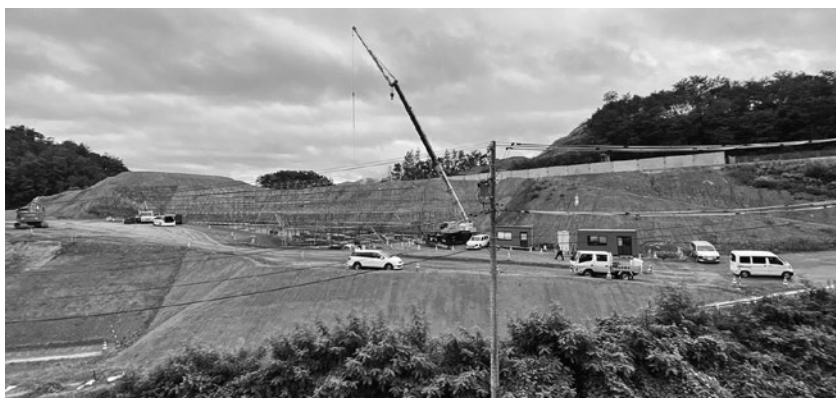
工事が進む筑北スマートインターチェンジ
