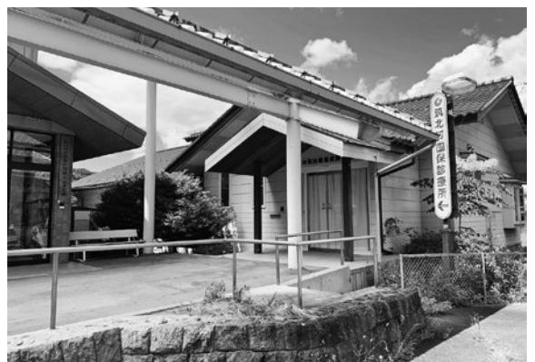
廃止となった筑北村国保診療所
