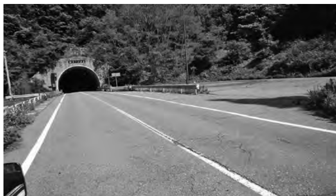
不法投棄が後を絶たない坂上トンネル入口付近
