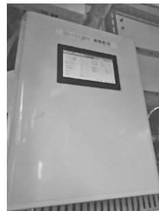
▲遠隔監視システムで薪の追加のタイミングを知らせる
