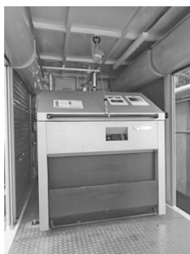
▲▶ドイツ製の薪ボイラーと貯湯タンク 着火約15分で完全燃焼し、その後は臭いがほとんどしないという
