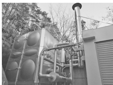
▲▶ドイツ製の薪ボイラーと貯湯タンク 着火約15分で完全燃焼し、その後は臭いがほとんどしないという
