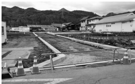
工事が進む団地予定地1棟を先行して建設し、内覧会を7月以降に実施
